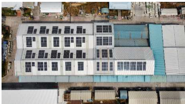
ภาพการติดตั้งเฟส 1 และ 2
